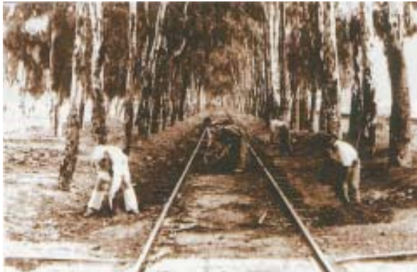
Trabajos de construcción en 1909, desde el puerto hasta la Punta del Sebo.
