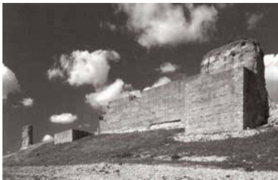
Murallas árabes de Tejada.
