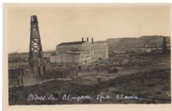
Sala de Máquinas.
