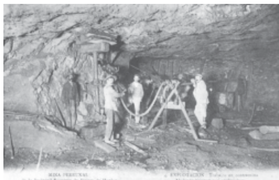
Extracción de mineral con barreno.
