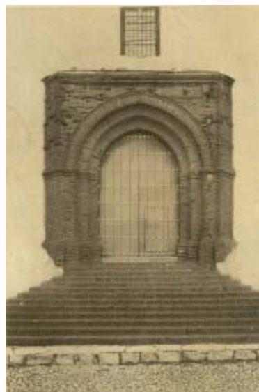
Puerta de entrada a la Iglesia de Santa Catalina, antigua sinagoga perteneciente al convento de las Carmelitas Descalzas.
