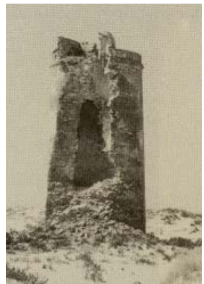
Torre Zalabar (parte posterior)
