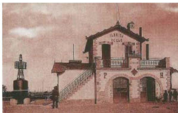
la Fábrica de Gas, necesario para las boyas de balizamiento.
