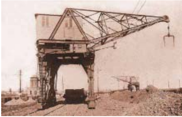
Grúa eléctrica de los depósitos de minerales adquirida en 1912.
