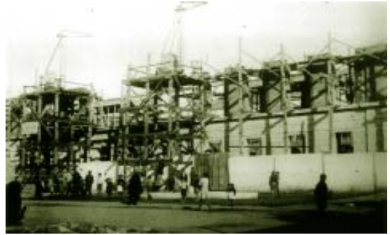
Construcción del Ayuntamiento.
